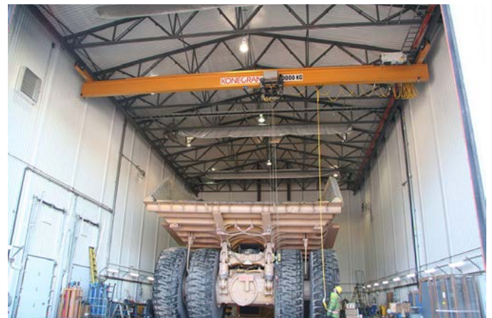
Econox hybride avec pont roulant suspendu 10 tonnes
