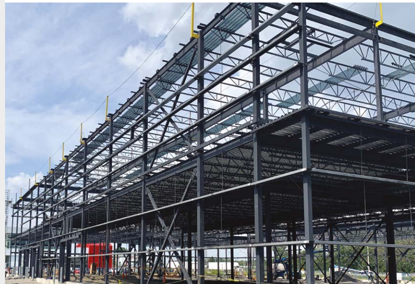
Poutrelles, tablier métallique et entremises fournis par Canam
