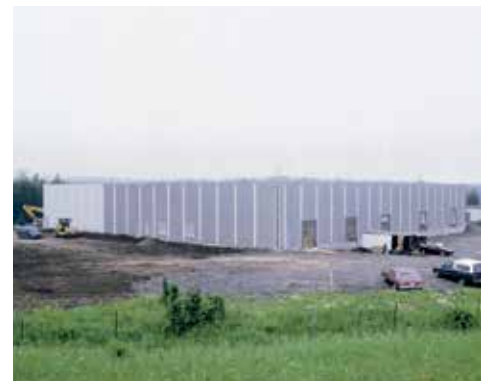
Fin du chantier
